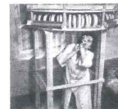
Der Aufbau des Kontrabators aus Hohlleiterringen, in denen die Umwandlung von Radarwellen in eine Kraftwirkung stattfinden sollte.
